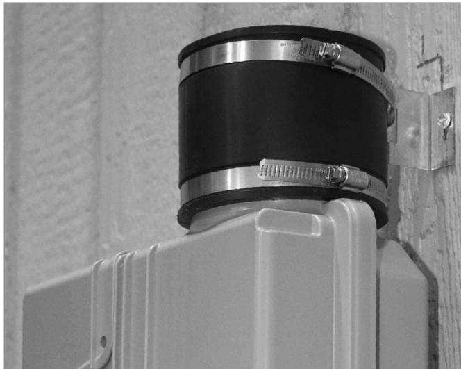
9. Insérez la conduite d'évacuation (article 7 non inclus) dans le raccord de conduit souple et serrez le collet de serrage.
