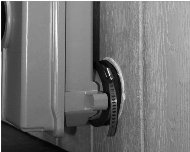
8. Enroulez le collet de serrage raccordé au support de fixation autour du raccord de conduit souple, mais ne le serrez pas.
